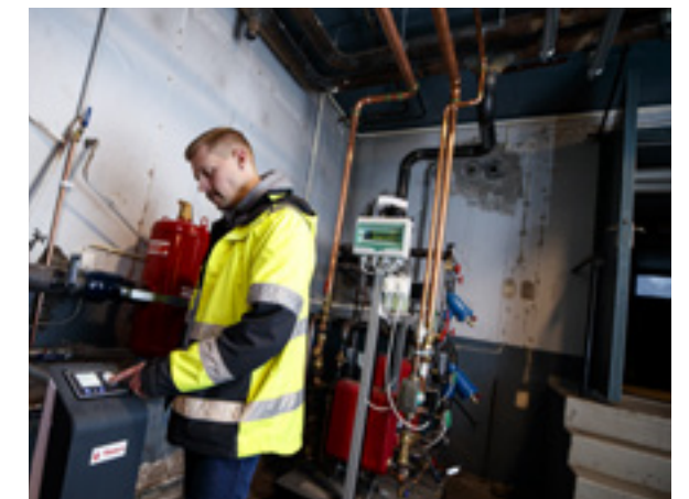
Johan Enström vid den nya undercentralen på Boken 12.
