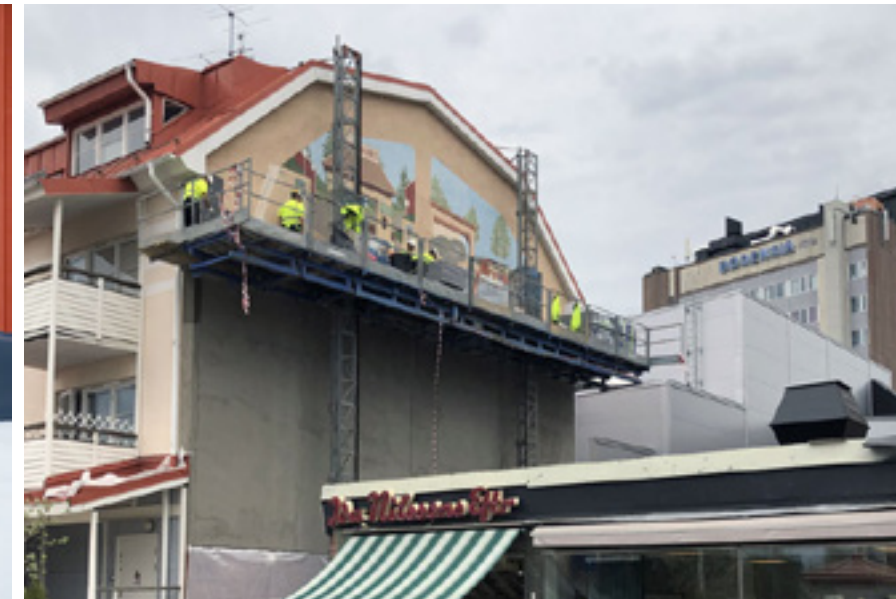
Fasadputs på Färgaregatan 10.
